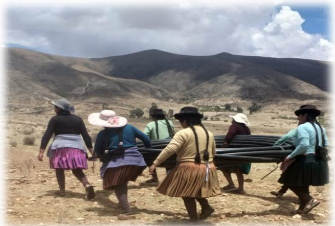
Frauen aus Corma tragen die Rohrleitungen den Berg hinauf.
