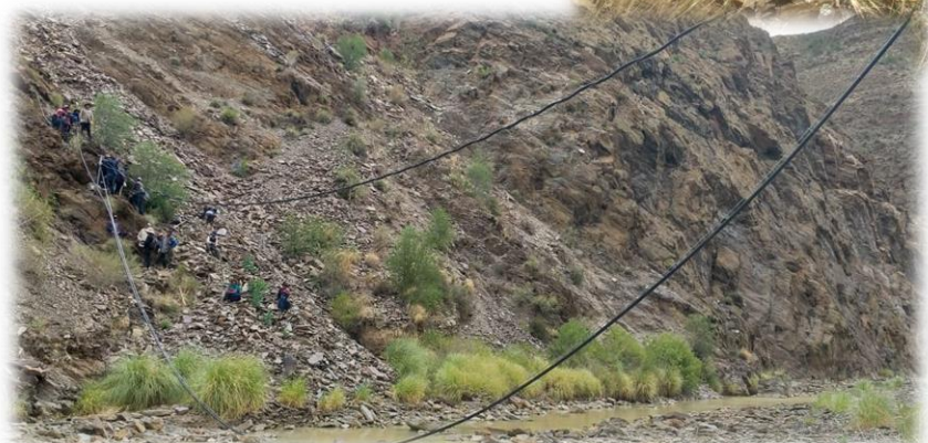
Verlegung der Rohrleitungen durch die Hügel von Corma.
